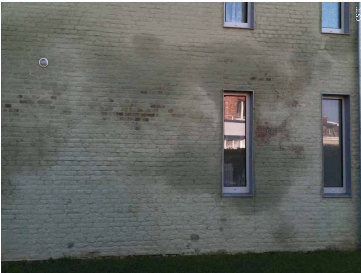
Fig. 6 Humidité non liée à la capillarité depuis le sol : cette large tache de forme irrégulière est sans doute due à la présence de nitrates dans la maçonnerie.
