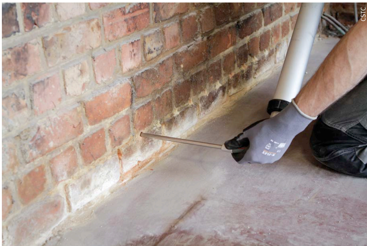
Fig. 5 Le produit hydrophobe est injecté à l'intérieur de trous forés préalablement dans le mortier à intervalles réguliers le long d'une ligne horizontale.
